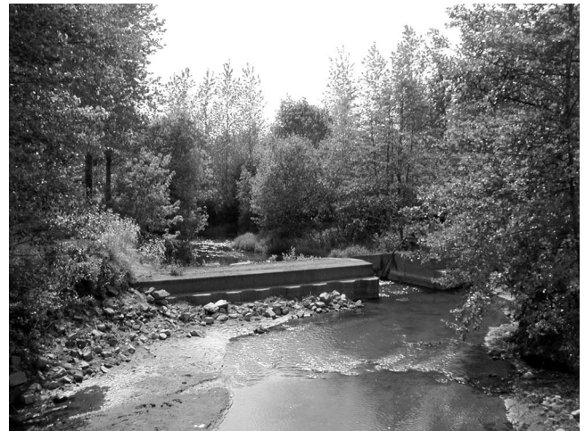
Photo 1 : Le déversoir en béton de la Motte, clapet manuel abaissé en rive droite.
