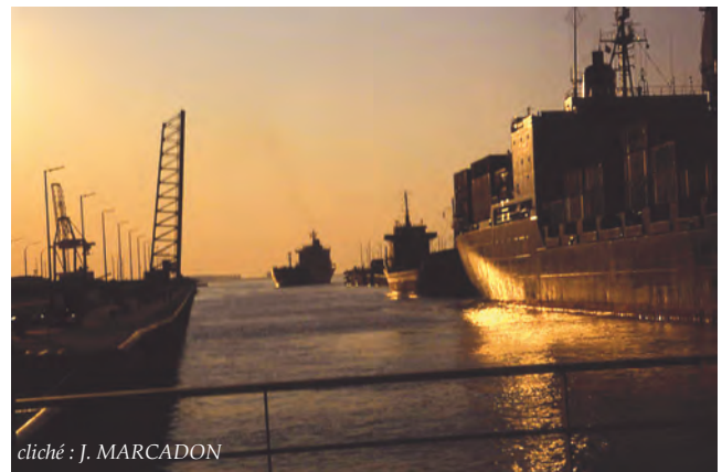
Fig. 1 - Anvers, Berendrecht, la plus grande écluse du monde (500 m x 68 m)
