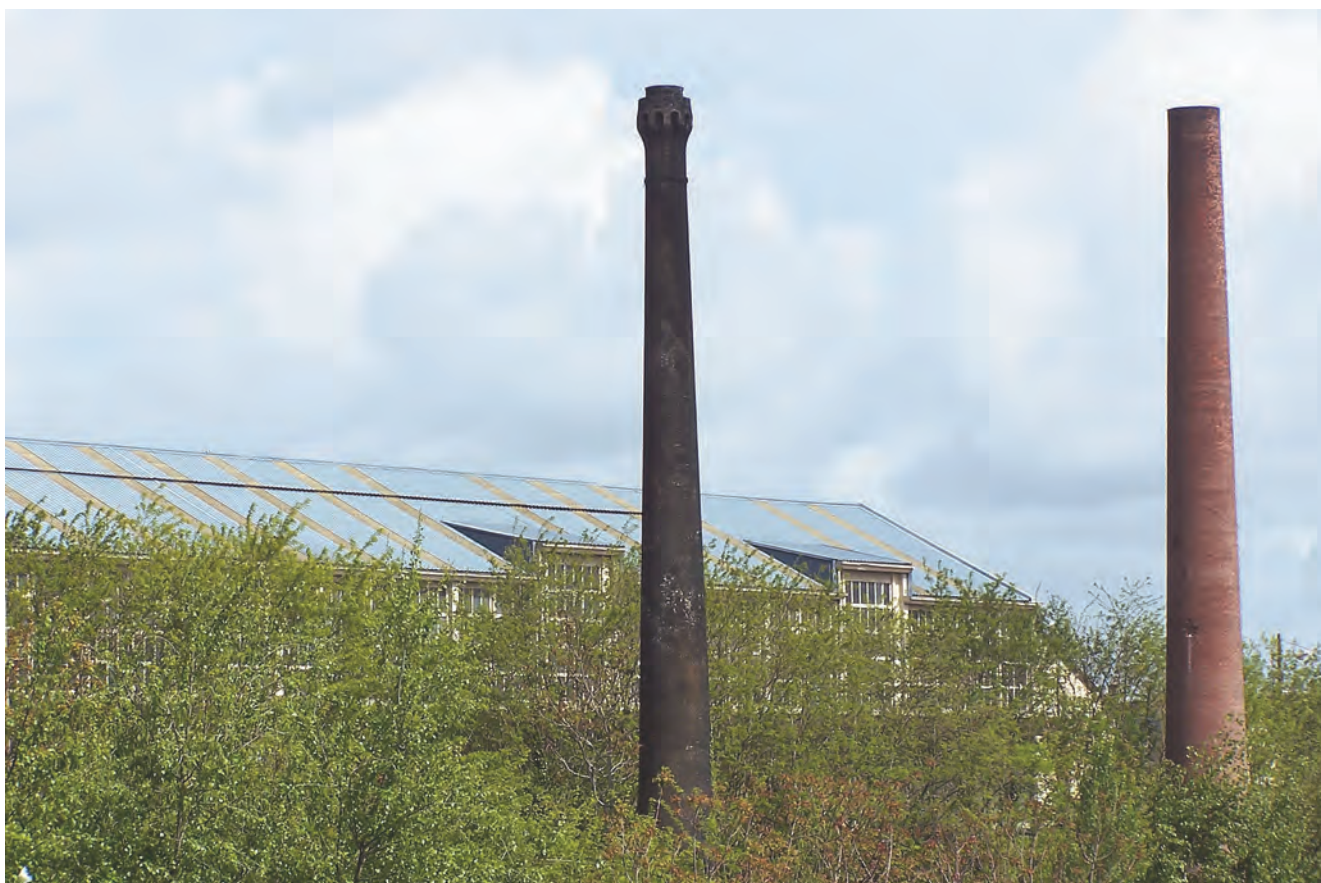
Photo 2 - Cheminées des Gaubourgs juste avant leur démolition (Vincent Veschambre, mai 2004).
